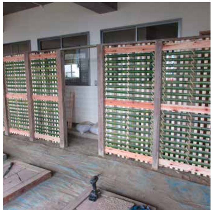
Saviaidan tekoa harjoiteltiin sisätiloissa. Aidan puuosat ovat japanin seetriä ja rappauksen sisälle jäi kaunis bamburakenne.
